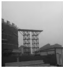
图5 支架安装完成 Fig.5 Support installation
